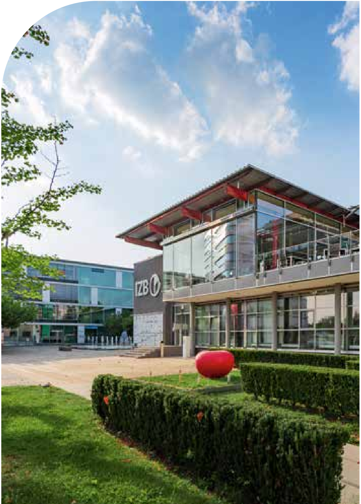
Eingang des IZB / Entrance of the IZB
