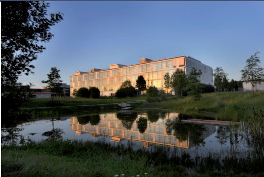
Здание IZB West 2 в IZB Мартинсрид с офисными и лабораторными помещениями на 3 000 кв. метрах, соответствующим требованиям учредителей новых предприятий в области биотехнологий
